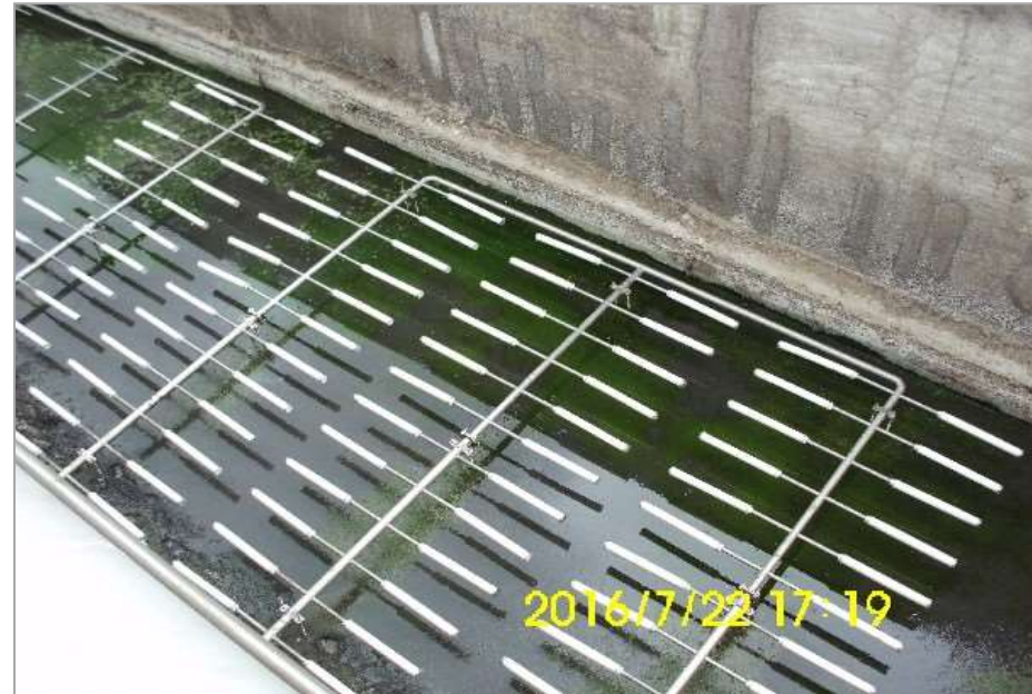
Пример реализации проекта очистных сооружений г. Бреста, Брестская область. (производительность 120 000 м 3 /сут.). Ремонт аэротенка.
