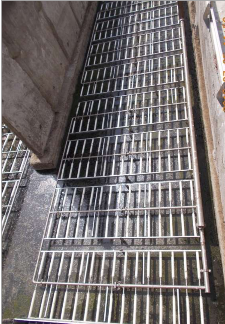
Пример реализации проекта очистных сооружений г. Бреста, Брестская область. (производительность 120 000 м 3 /сут.). Ремонт аэротенка.
